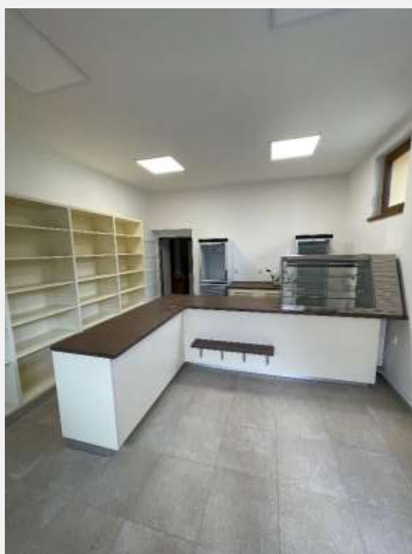
Rekonstrukce obchodu v obci Lhotka
